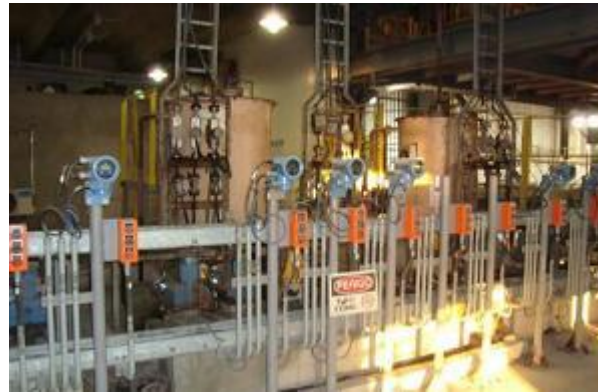
Figura 2. Sistema de dosagem de reagentes com bombas de diafragma
